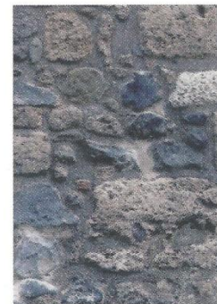
Particolare della costruzione muraria del campanile formata da materiali di riutilizzo
